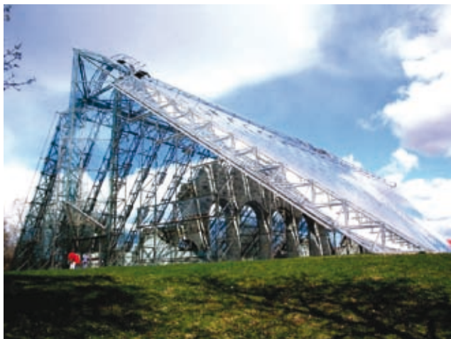
Obr. 6: Hamar (Norsko). Krycí konstrukce chránící dochovaná a archeologickým výzkumem odkrytá torza dómu. Foto: T. Frogner, Hamar.
