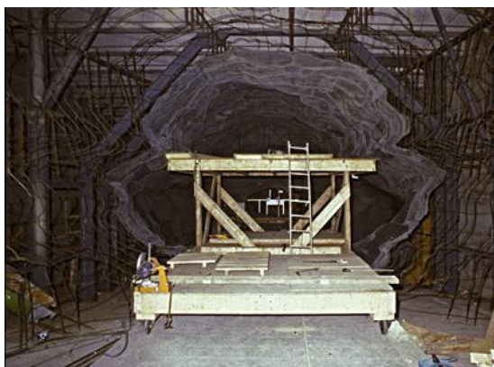
Obrázek 1: Výstavba umělé jeskyně Lascaux II
